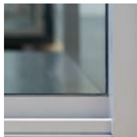
Detalle exterior de marco: lateral - inferior
